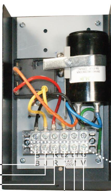
2 fils de l'interrupteur à pression, non polarisée.
